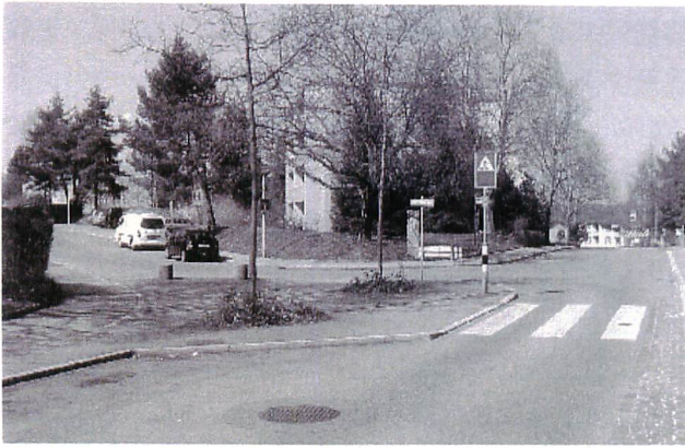
■写真—12 歩行者滞留スペースを多く取る代わりに横断歩道部の車線を減少させ、横断距離を短縮させている 【Lerchenrainにて撮影】
